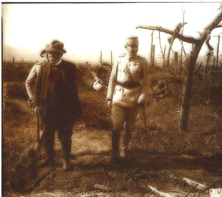
Clemenceau et son fils dans les tranchées 25
