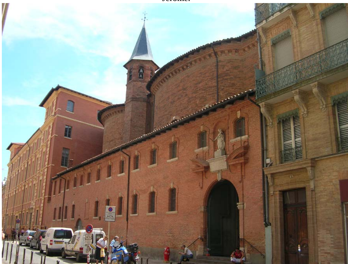
Fig. 6 : Mur de clôture de la chapelle des pénitents bleus, actuelle église Saint-Jérôme.
