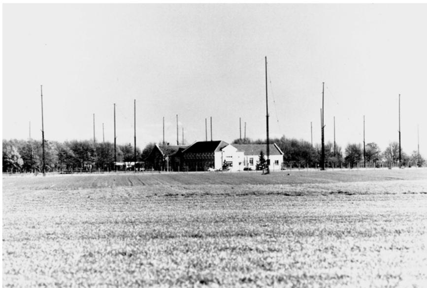
**Centre récepteur de Saint-Lys (1990)** - Le bâtiment d'exploitation entouré de son champ d'antennes composé d'aériens directifs en « losange » et omnidirectionnels en « carré Gouriaud ».
